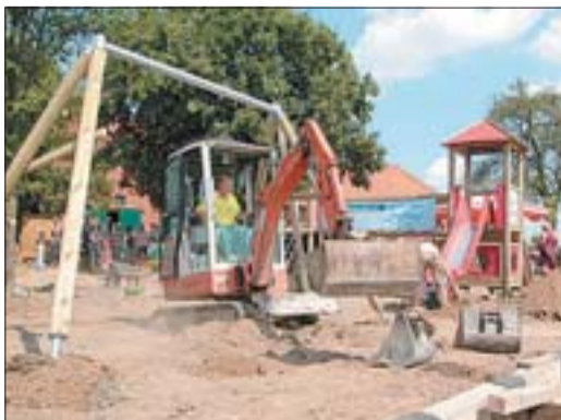
Die Arbeiten laufen bis zum letzten Moment: Sebastian Unger von der beauftragten Baufirma glättet den Boden vor der Doppelschaukel.
